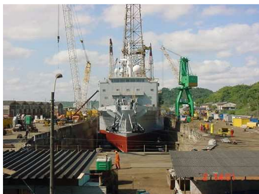
O SELENA é constituído por uma plataforma que pode ser abaixada até a profundidade de 6 metros, permitindo que a embarcação inicialmente flutue sobre ela.
