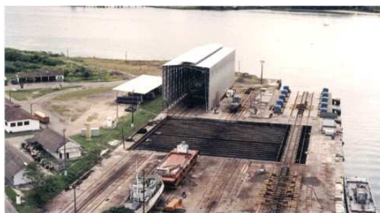
O SELENA é constituído por uma plataforma que pode ser abaixada até a profundidade de 6 metros, permitindo que a embarcação inicialmente flutue sobre ela.
