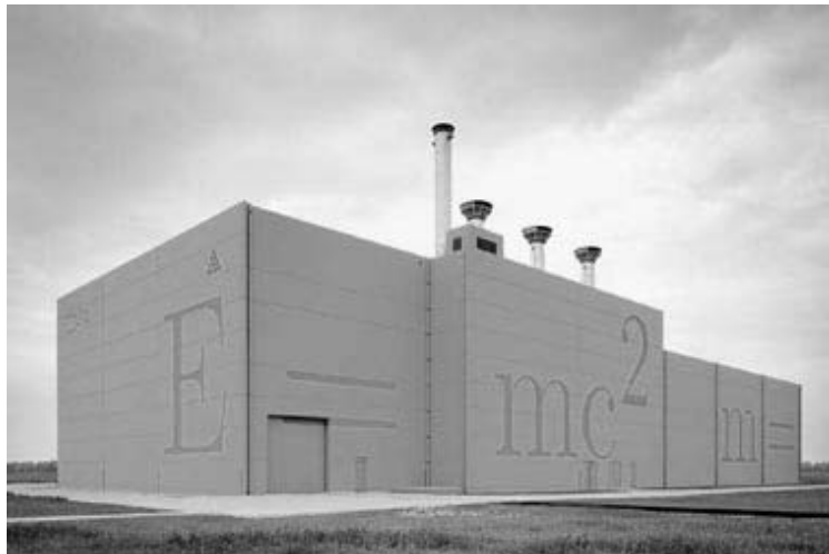
Figura 4.13 - Instalação de armazenagem de CNQ, HABOG, Holanda
