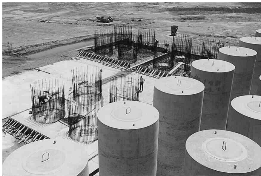
Figura 3.17 - Instalação de silos verticais de concreto armado para armazenar CNQ em instalações externas.
