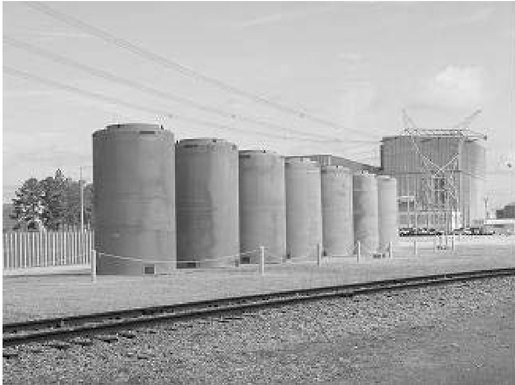
Figura 4.7 - Cascos de concreto para CNQ com ventilação por dutos, Plant Hatch, EUA Fonte: www.holtecinternational.com , 2004
