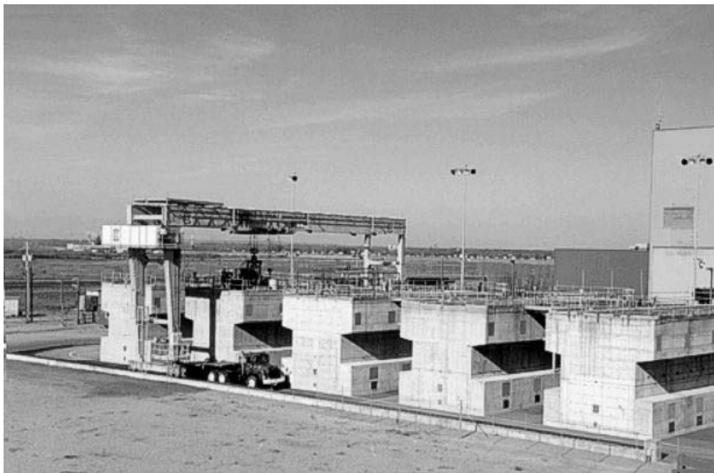
Figura 4.17 - Sistema modular de armazenagem seca MACSTOR
