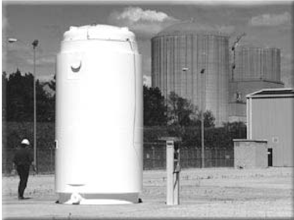
Figura 4.9 - Casco para armazenagem de CNQ, Pairie Island, EUA Fonte: http://www.ilsr.org/columns/2003/pifseconomics.html
