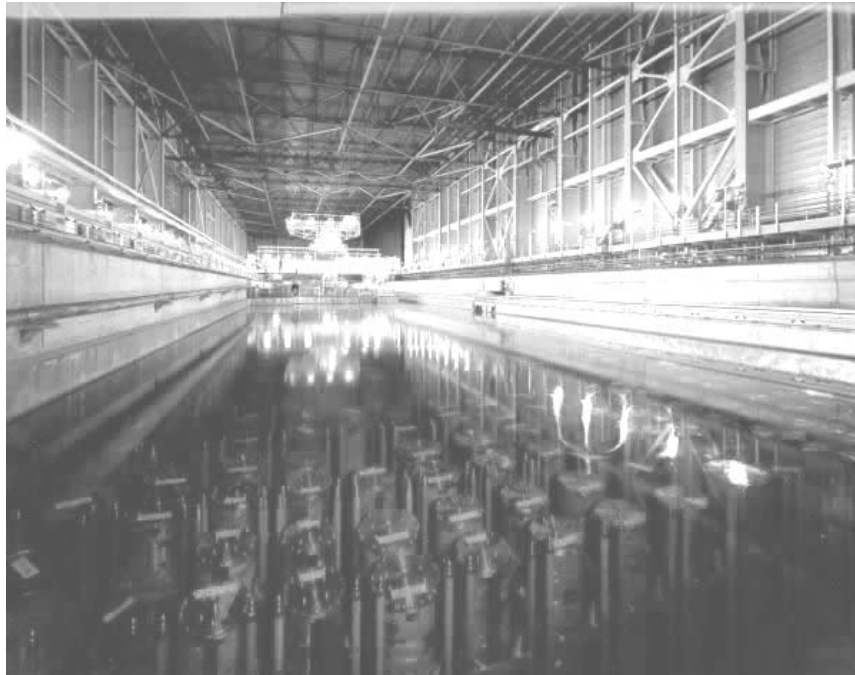
Figura 4.16 - Piscina de armazenagem temporária de curto prazo em Sellafield, Reino Unido
