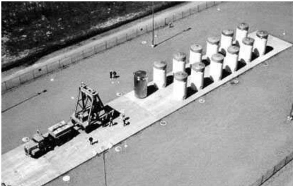
Figura 4.8 - Instalação de armazenagem de CNQ, Surry, EUA. Fonte: Bunn et al, 2001
