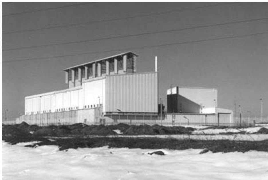
Figura 4.15 – Vista externa da instalação de armazenagem de CNQ, PAKS, Hungria
