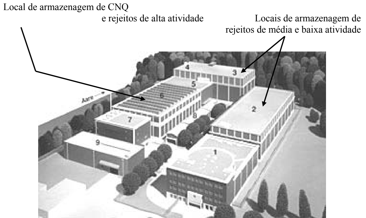
Figura 4.19 - Instalação de ZWILAG, Suíça, para armazenar CNQ em via seca Fonte: http://www.zwilag.ch (2004)
