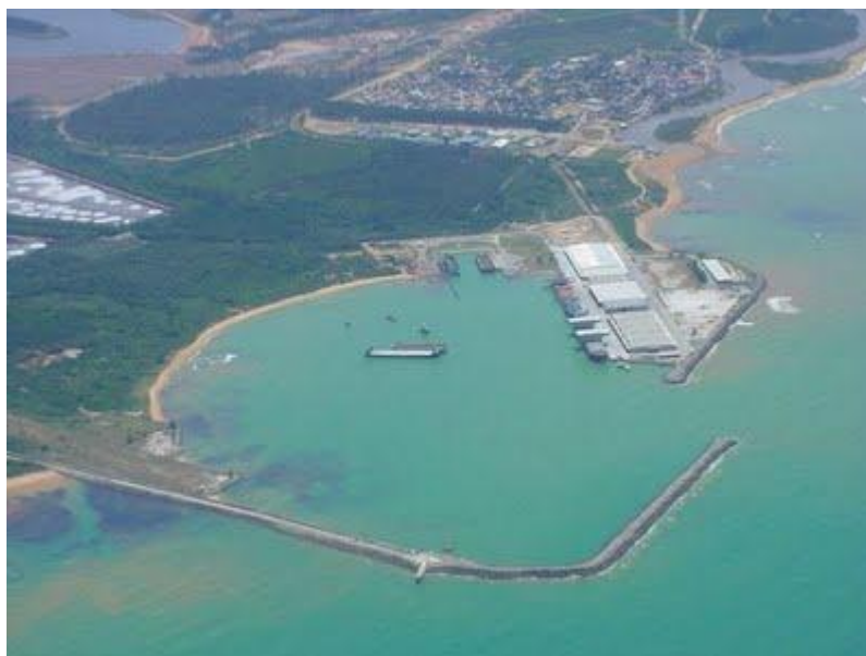
Figura 4.1.1 – Vista aérea de Barra do Riacho.
