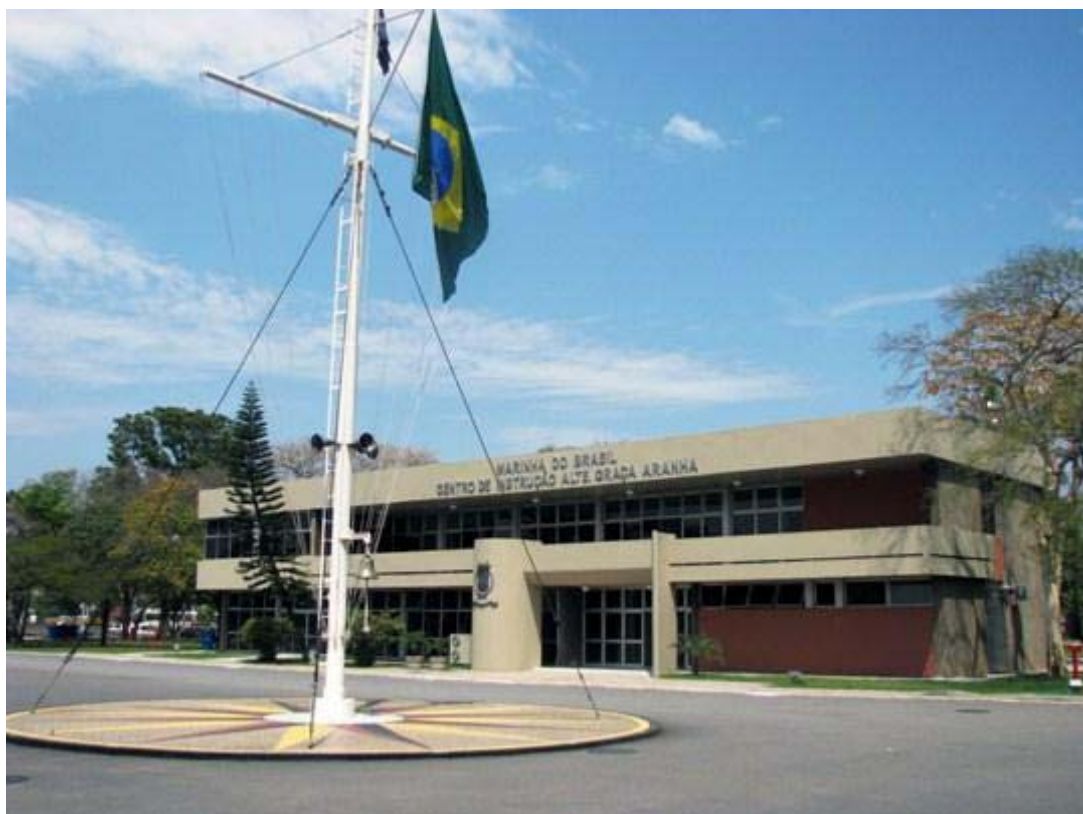
FIGURA 2: Bloco de Comando localizado próximo ao Pátio da Bandeira
