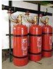
Fig. 11: Sistema Fixo de Dióxido de Carbono
