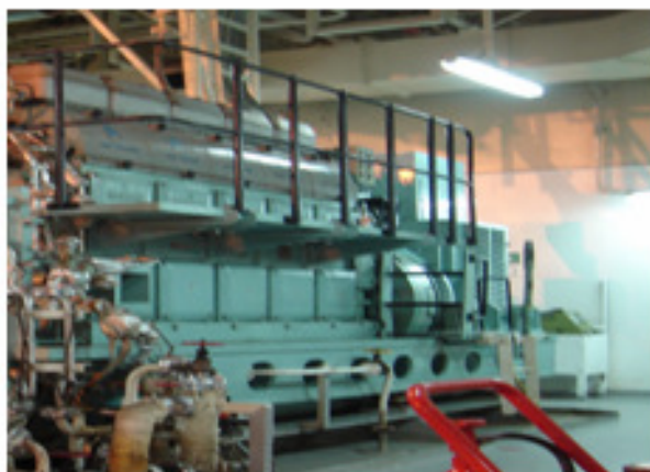
Figura 2: Praça dos geradores./ Fonte: foto do autor.
