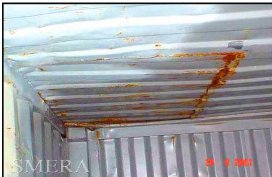
Figura 15: A chapa inserida no teto do contêiner apresenta grande oxidação na costura da solda podendo afetar a estanqueidade do contêiner.
