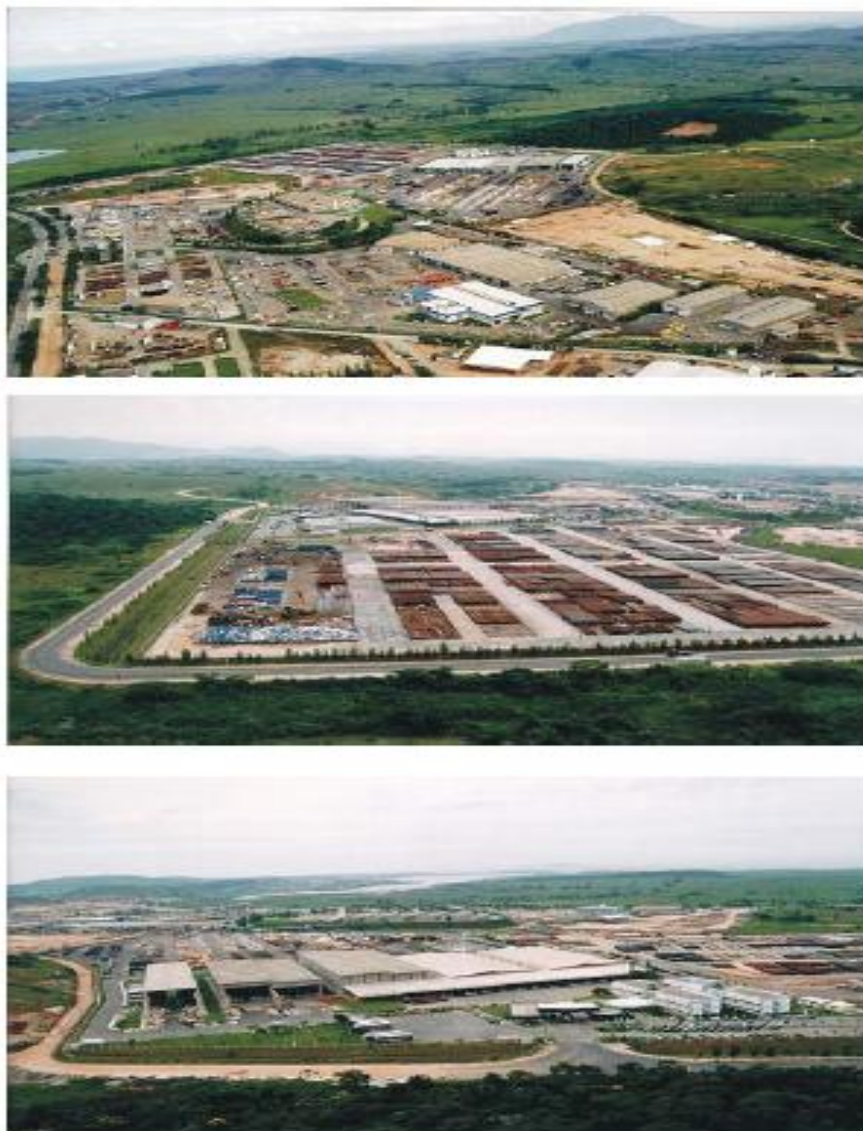
Foto 8 – Parque de tubos
