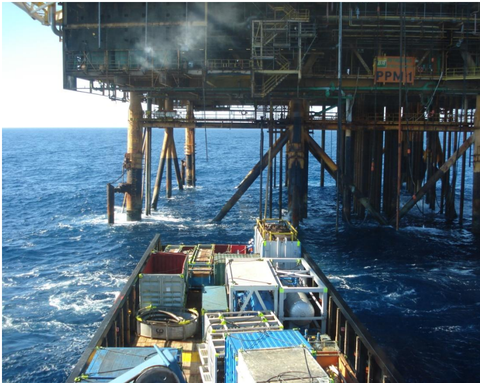
Foto 7– Embarcação de apoio em operação com a plataforma PPM-1
