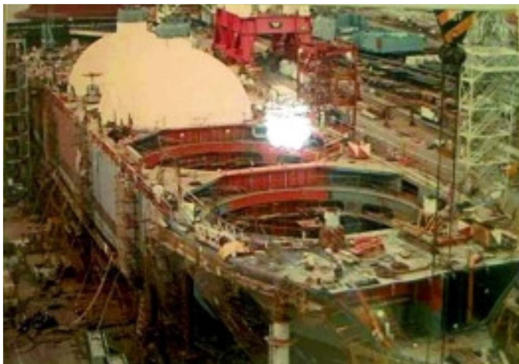
Figura 21 - Primeira camada de tinta “primer”
