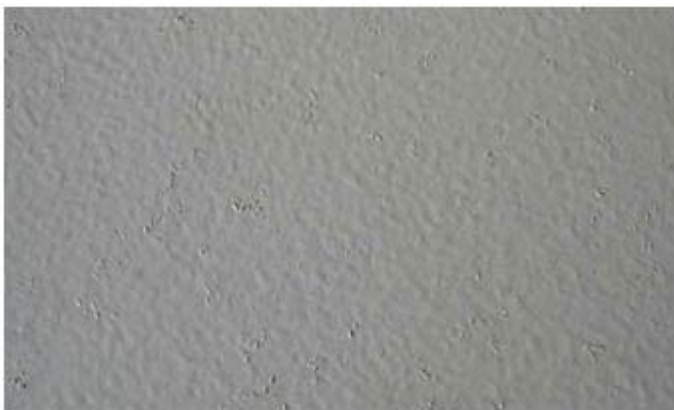
Figura 36 - Inclusão de pêlos Fonte - www.rennermm.com.br
