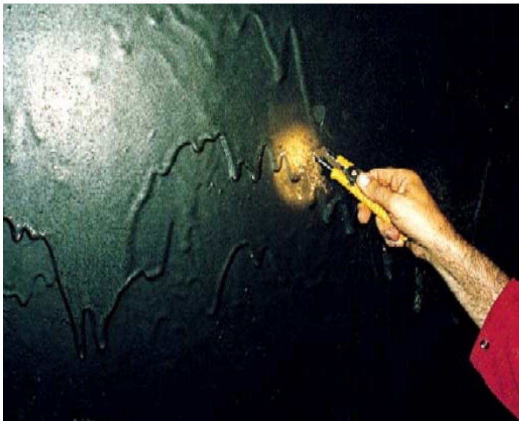
Figura 29 - Escorrimento ou decaimento Fonte - http://www.embratecno.com.br
