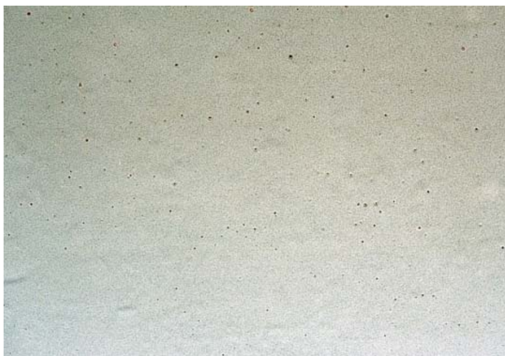
Figura 32 - Porosidade ou presença de poros
