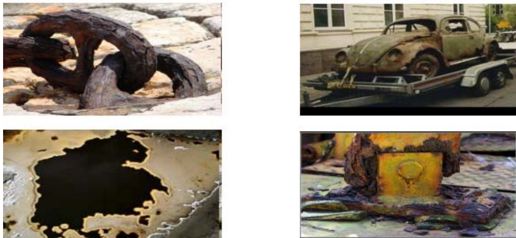
Figura 1 – Processos corrosivos Fonte - http://www.csemil.com.br
