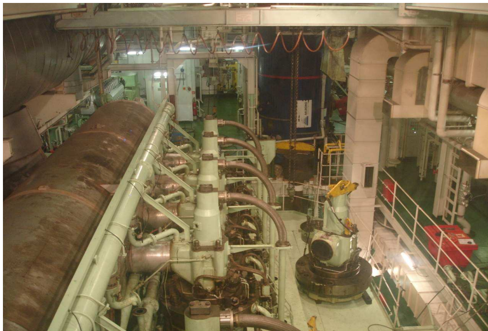
Figura 6 - Manutenção no cabeçote do motor principal
