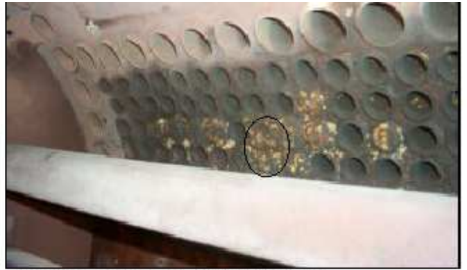
Presença de 12 tubos geradores buijonado na região da cortina d'água
