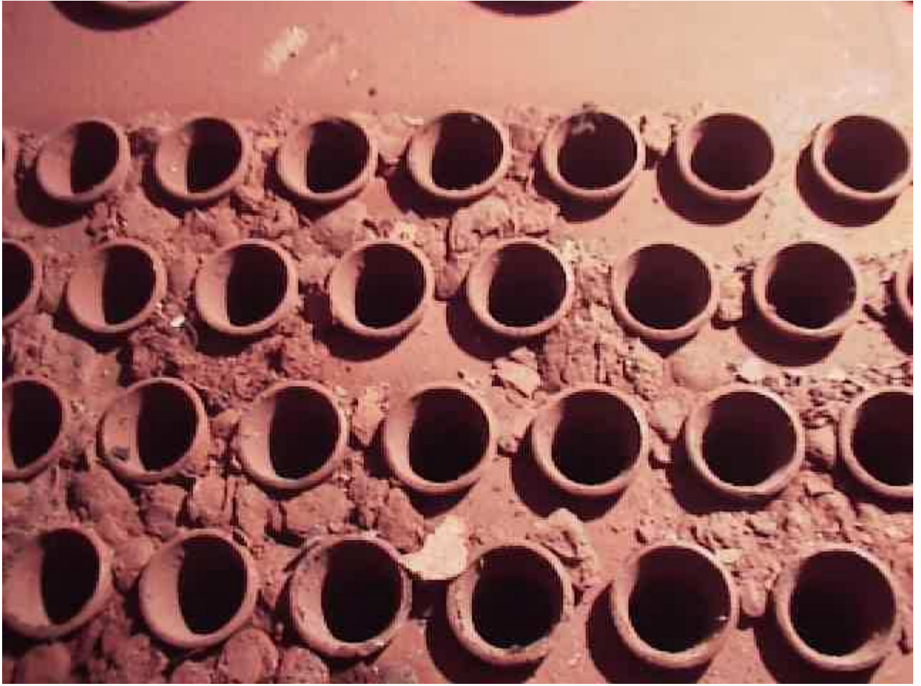
Retorno pelo Condensado, Corrosão no Sistema – Fonte: Drew Ameroid Marine USA 1992
