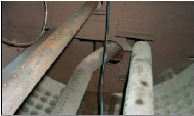
Presença de 12 tubos geradores buijonado na região da cortina d'água
