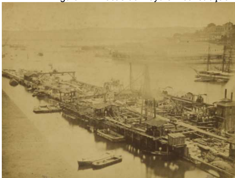
Figura 4 – Docas do Lloyd em construção
