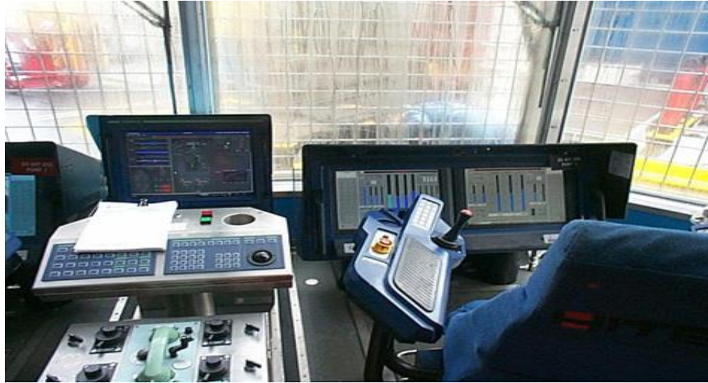
Figura 3.1 – Driller’s DOG HOUSE” (Cabine de Sondador)
