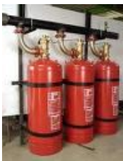
Fig. 10: Sistema Fixo de Dióxido de Carbono
