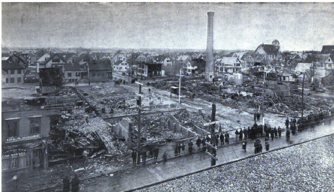
Figura 8 – Fábrica Brockton depois da explosão
