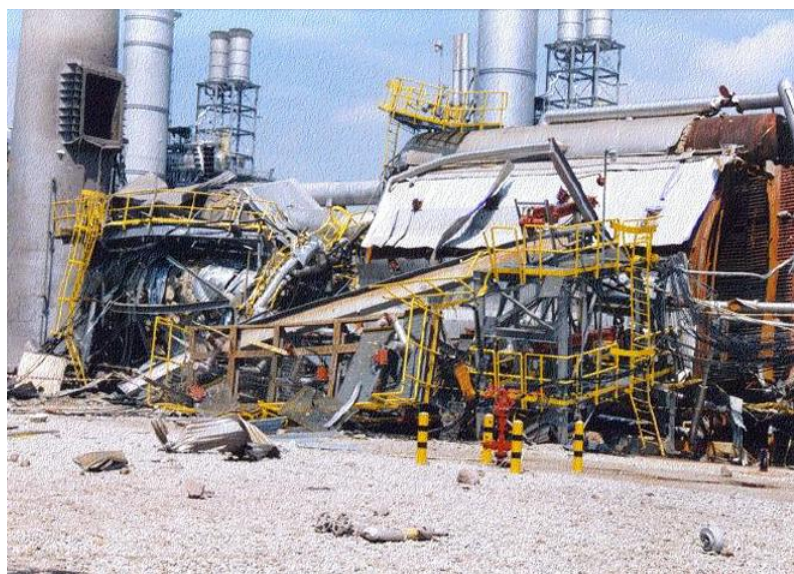
Figura 17 – Caldeira Exxon Mobil, depois do acidente
