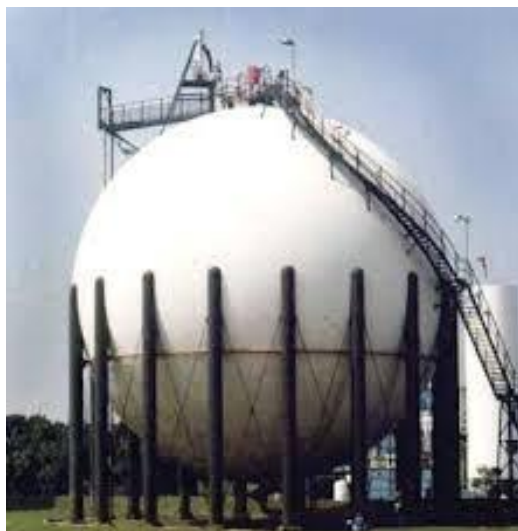
Figura 2 - Vaso de pressão esférico
