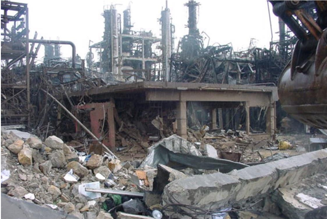
Figura 19 – Refinaria Sonatrach Skikds, depois da explosão
