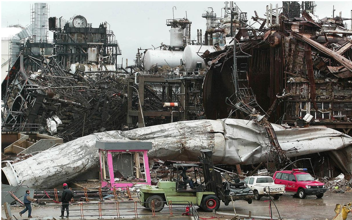
Figura 20 – Refinaria Sonatrach Skikds, depois da explosão
