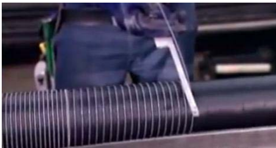
Figura 20 – Assentamento do espiral metálico realizado manualmente(PREMIER RUBBER CO,2012)
