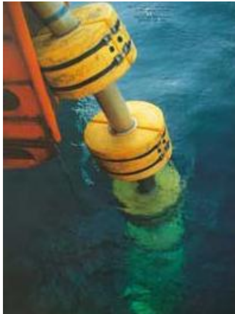
Figura 2 - Flutuadores instalados no duto flexível
