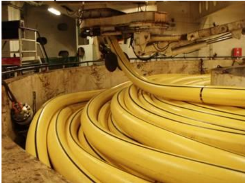
Figura 14 - Duto acondicionado em cesta.
