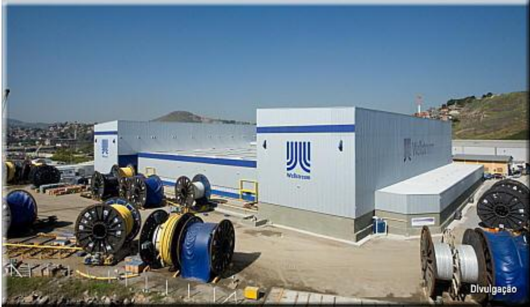
Figura 15 - Armazenamento de bobinas no pátio.
