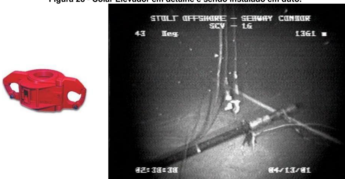
Figura 28 - Colar Elevador em detalhe e sendo instalado em duto.
