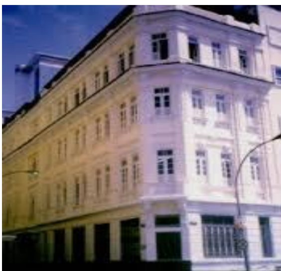
Figura 14: Sede da Diretoria de Portos e Costas – Rio de Janeiro - RJ
