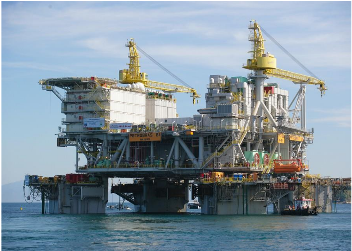
Figura 5.7: Deck mating da plataforma TLWP P-61 – operação para unir o casco ao convés da unidade
