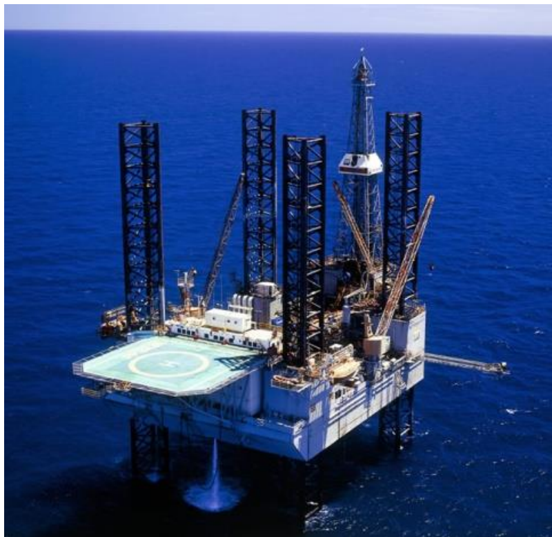
Figura 5.2: Plataforma autoelevável P-5 operando no litoral do Rio Grande do Norte
