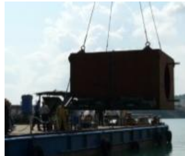
Figura 31 – Colocação na água
