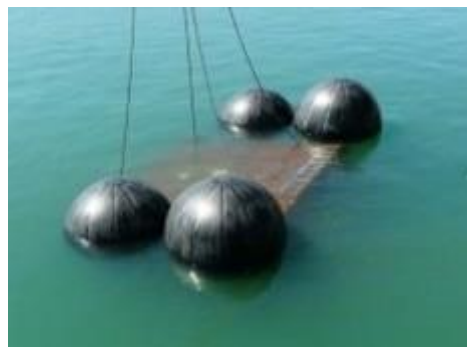
Figura 41 – Inflação dos balões
