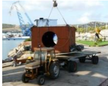
Figura 25 – Colocação no estaleiro
