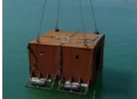
Figura 39 – Colocação no mar
