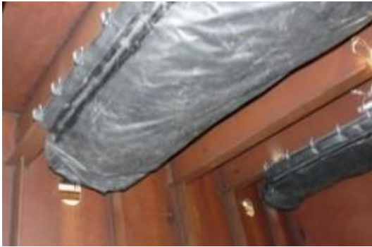
Figura 23 – Instalação dos balões internos
