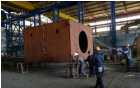
Figura 19 – Posicionamento da estrutura
