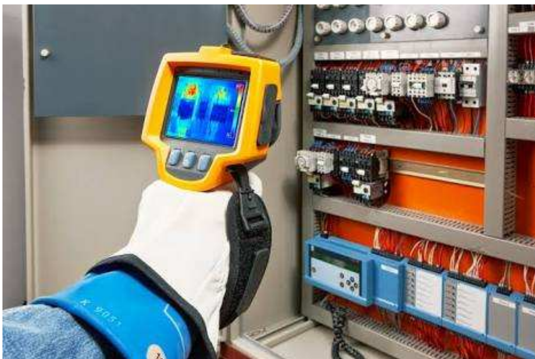
Figura 8: Termográfica (sensoriamento em painéis elétricos)
