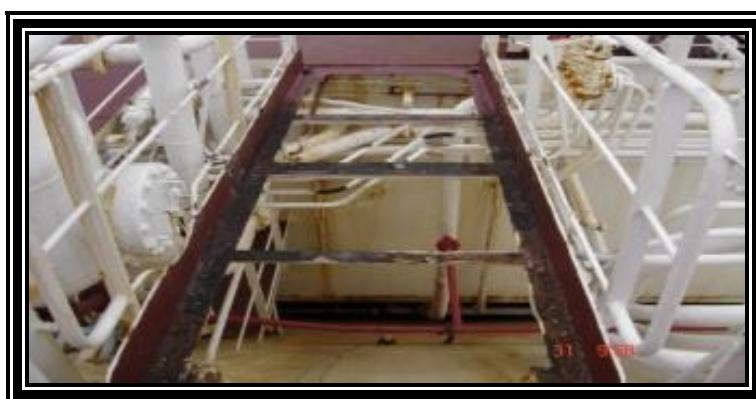
Figura 5 - Confeccionar passarela do comprimento dos compressores de carga para o tanque 1
