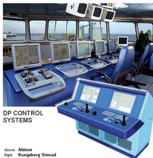
Figura 5- Consoles de controle de um sistema DP
