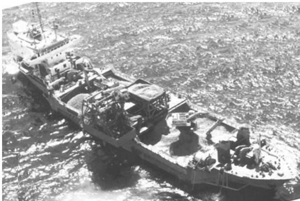
Figura 21: Navio de lançamento de rochas.
