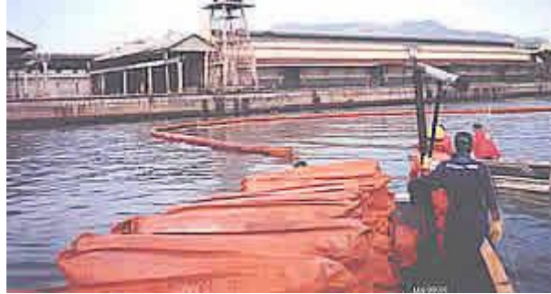
Figura 5.4. Lançamento de barreira de contenção
