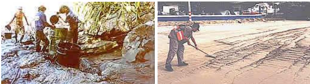
Figura 5.10. Limpeza manual de costões rochosos e praias
