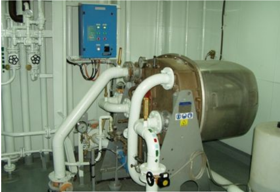
Figura 11 - Destilador Alfa-Laval JWP 26 C80B. Fonte: www.alfalaval.com
