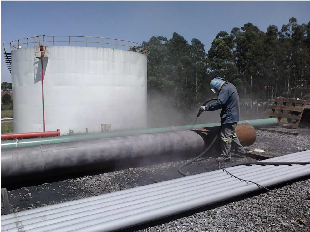
Figura 7 - Limpeza por jateamento abrasivo
