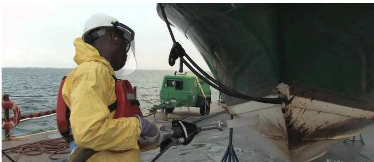
Figura 6 - Limpeza com martelete pneumático
