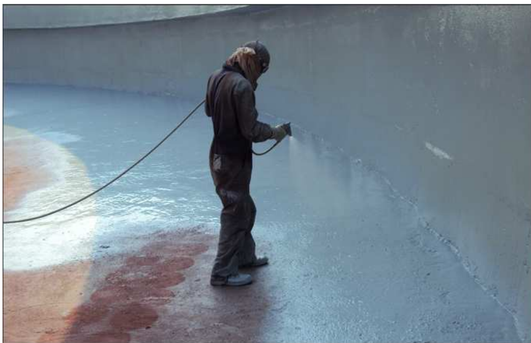
Figura 8 - Aplicação de tinta de fundo (primer)
