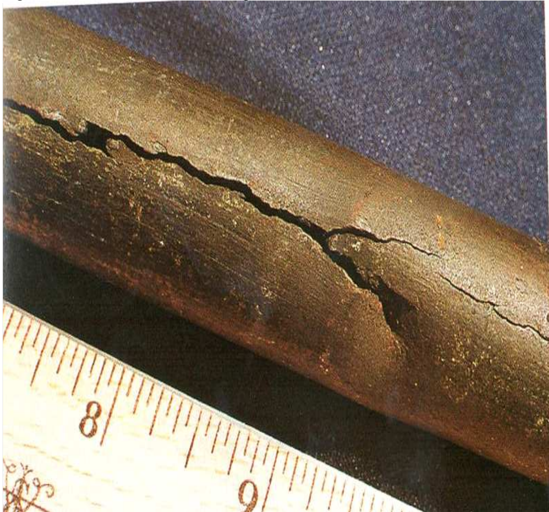
Figura 4 - Corrosão devido à tensão aplicada
