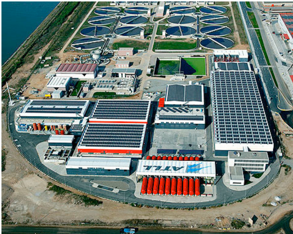
Figura 1 – Planta Industrial Osmose Reversa na Espanha
