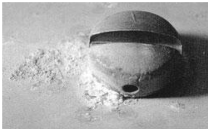
Figura 4: Corrosão na caldeira
