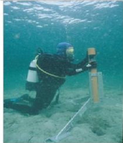
Figura 35 - Instalação de transponder
