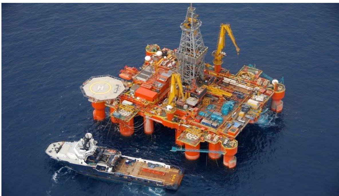
Figura 2.3 – Rebocador operando com plataforma
