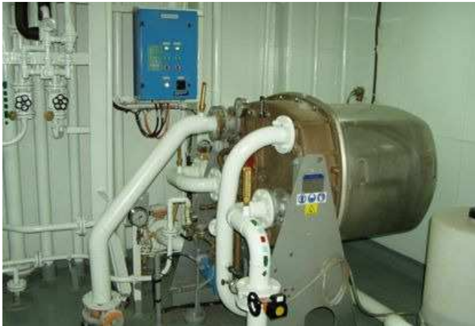
Figura 11 - Destilador Alfa-Laval JWP 26 C80B
