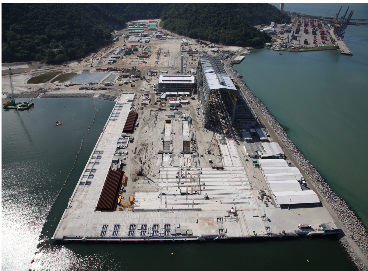
Figura 4 – Fotografia aérea da Área Sul do Complexo Naval de Itaguai (CNI), mostrando as obras do estaleiro de construção e a estrutura do Main Hall .
