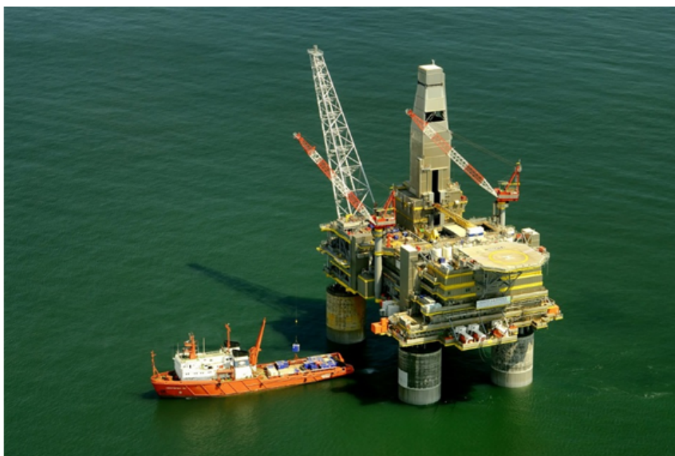
Figura 22: Operação de Transferência de Carga entre PSV e Plataforma
