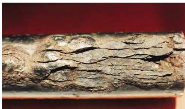
Figura 8: Chapa que sofreu corrosão por esfoliação
