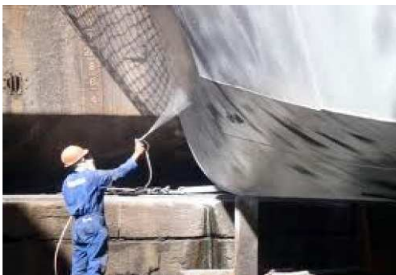
Figura 19: Pintura do casco de uma embarcação no dique seco
