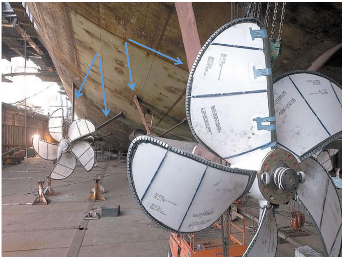
Figura 5 - Pés-de-galinha sustentando os propulsores
