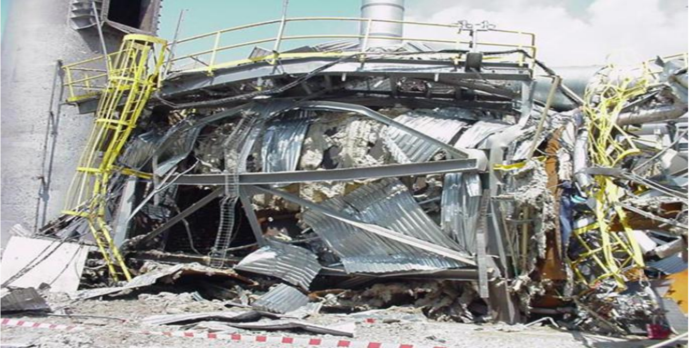
Figura 9 - Explosão ocasionada por uma caldeira
