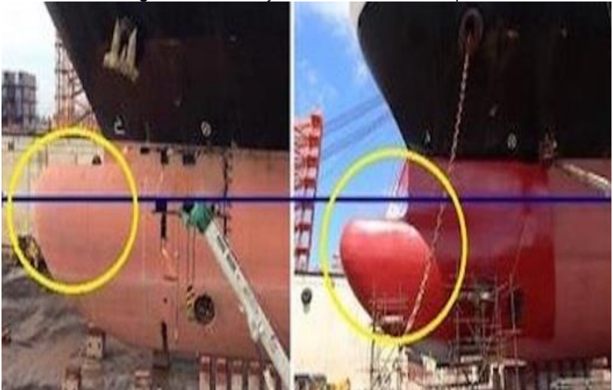
Figura 4 – Modificação estrutural no bulbo de proa
