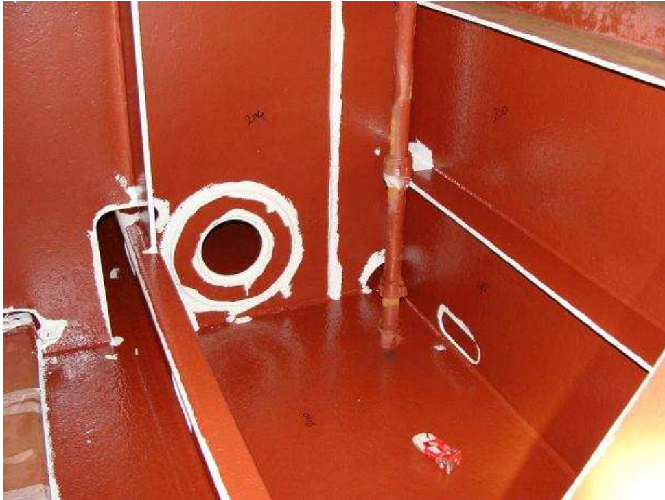
Figura 14 – Tratamento e pintura de tanque de carga
