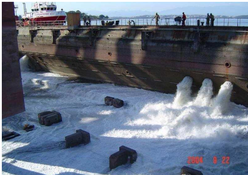
Figura 3 – Dique seco – Porta batel
