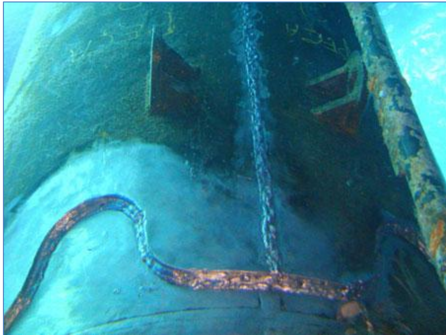
Figura 36 – Inspeção de Dutos
