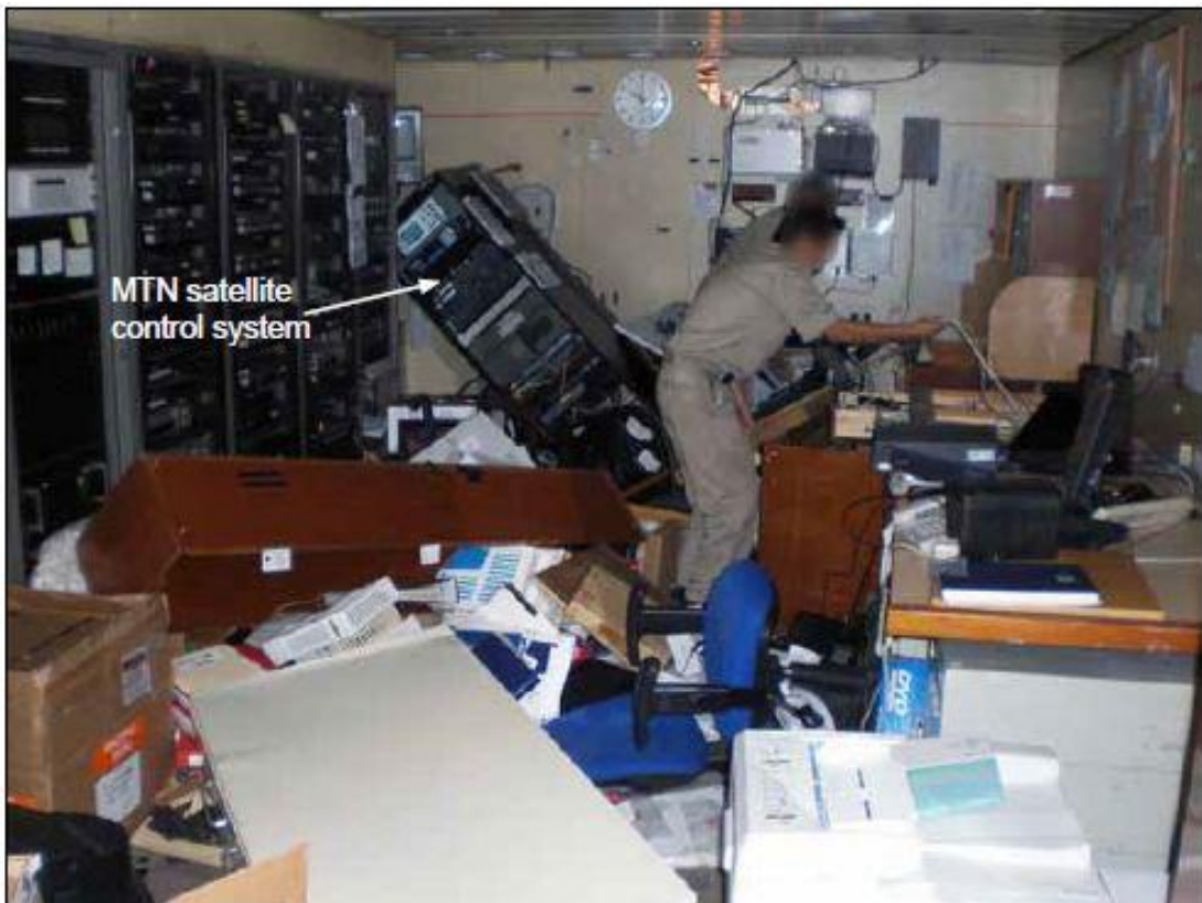
Figura 3.5 – Imagem mostra a sala de comunicações
