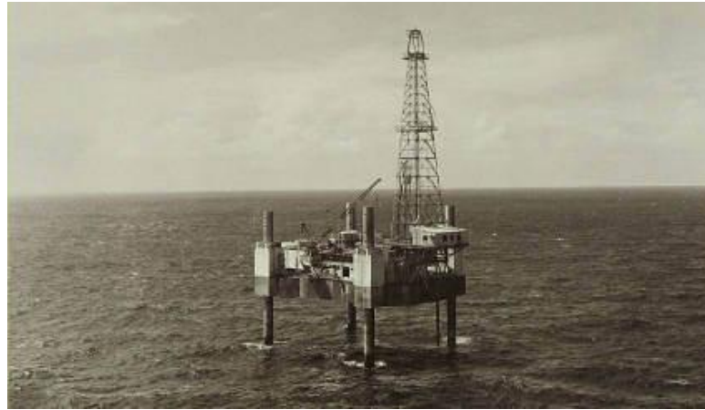
Figura 2 - Plataforma elevatória P-1.
