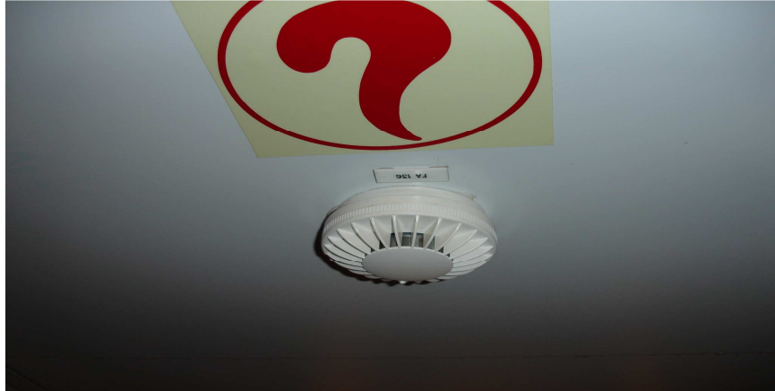
Figura 16 Detector de fumaça
