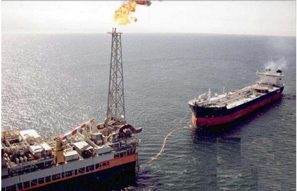
Figura 14: Navio aliviador em operação
