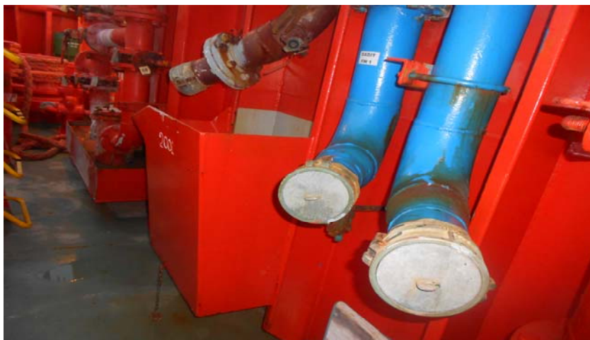
Figura 15: Bandejas de Contenção
