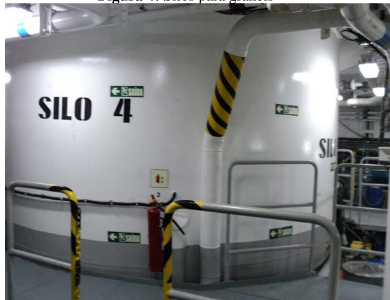
Figura 4: Silos para granéis
