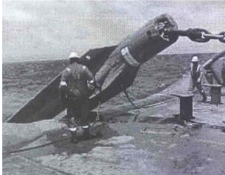
Figura 14: Lançamento da estaca de ancoragem.
