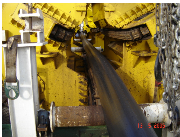
Figura 21: Linha no tensionador.
