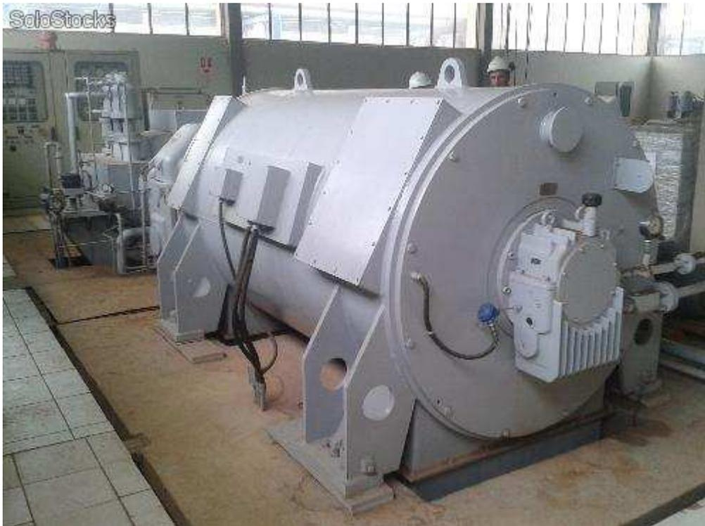
Figura 12- Turbo gerador 4000kw 21kg de pressão
