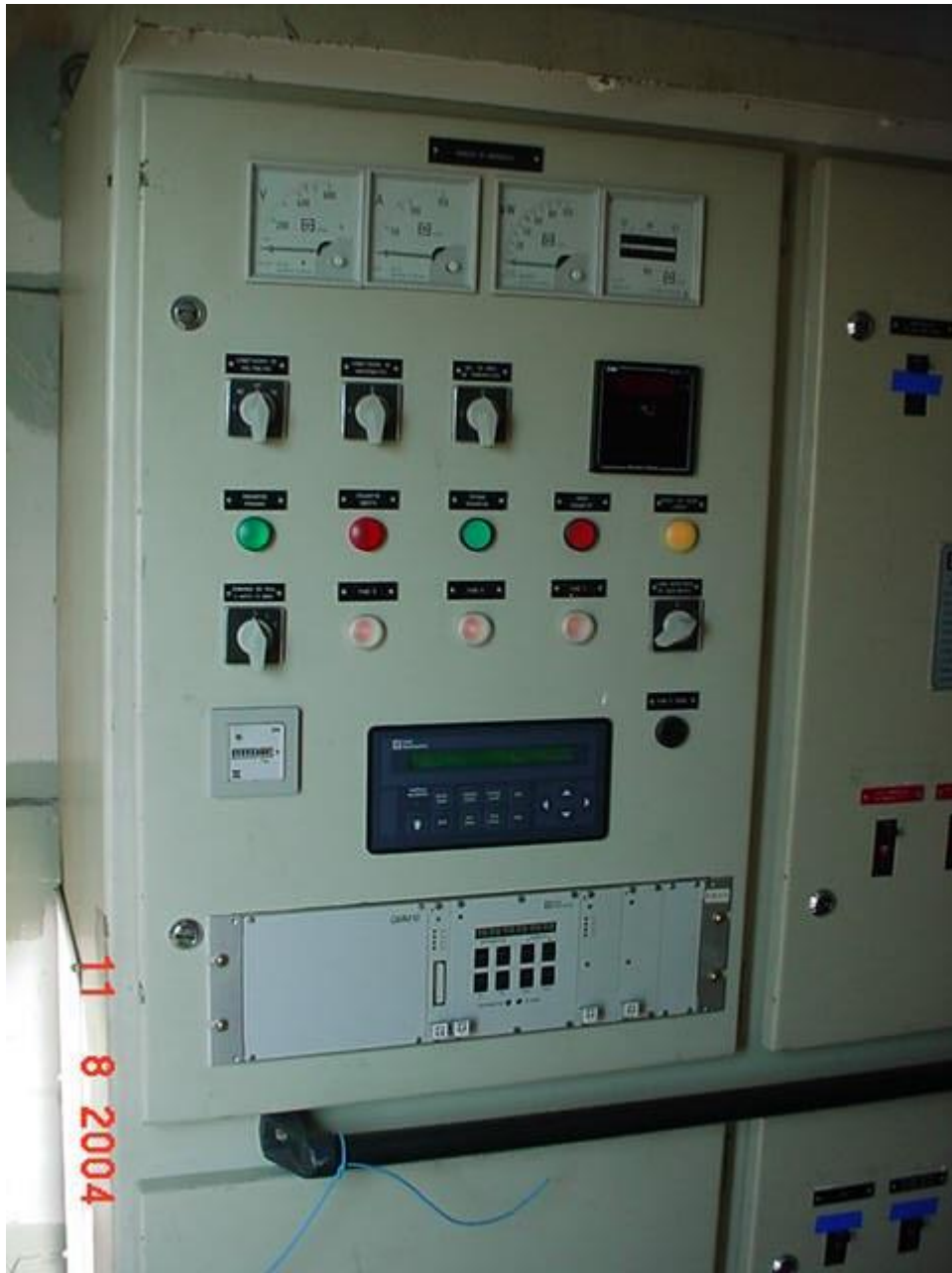
Figura 14 - Ilustração de um Quadro Elétrico de Emergência.
