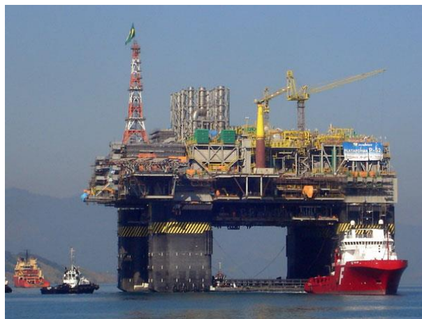
Figura 5 - Plataforma com Sistema de Posicionamento Dinâmico
