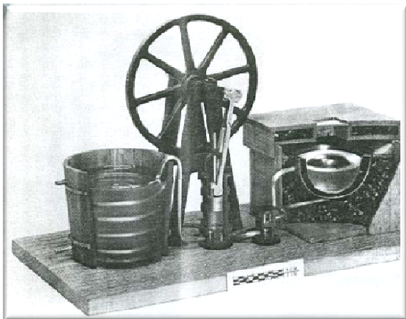
Figura 63 – Construção da Máquina de Gelo de Perkins
